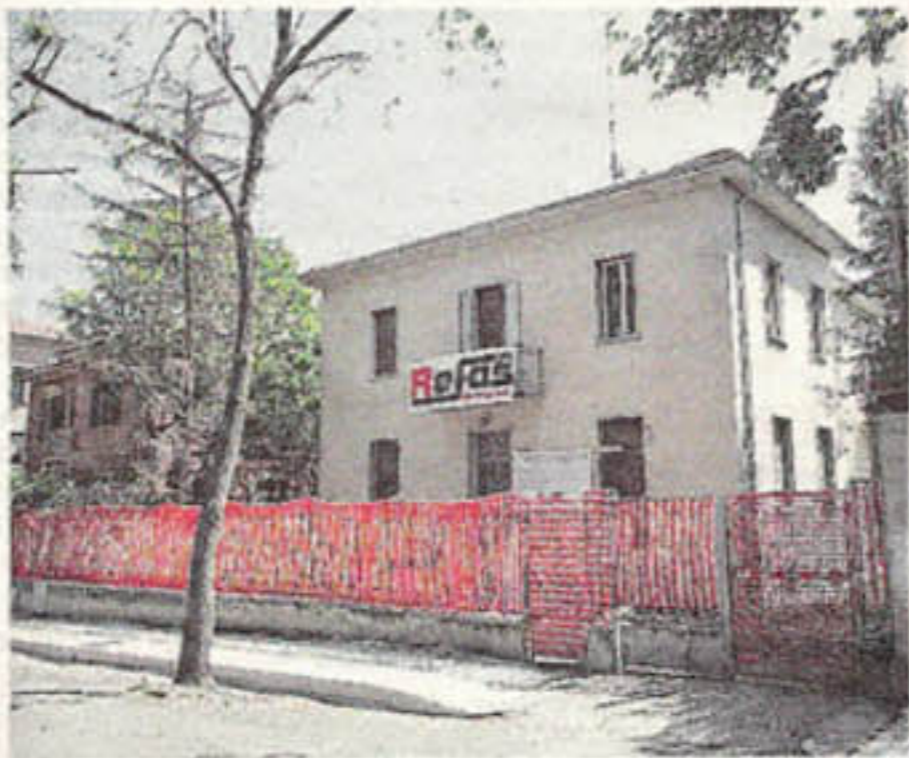
Il passato La palazzina in via Albertazzi 32 che verrà abbattuta
